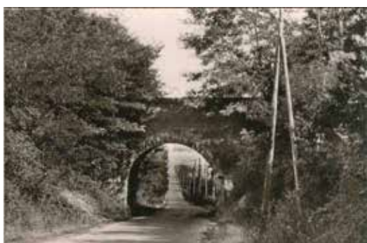
Ancien pont du canal route de Longages
