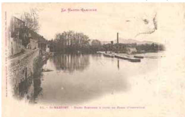
Saint Martory, usine Barthier et prise du canal
